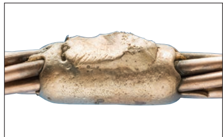
Fig. 29 – Conexión Cadweld finalizada.
