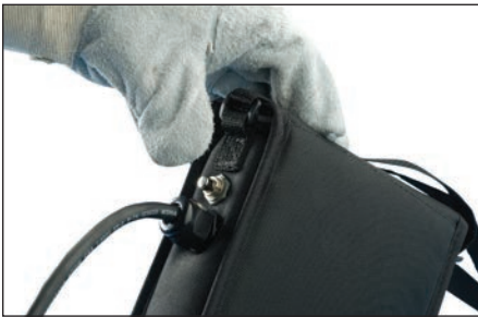
Fig. 26 – Usando el paquete de baterías de Cadweld Exolon, presione el botón. En este momento, la unidad enviará una carga a la espiga de encendido. La espiga de encendido iniciará la reacción aluminotérmica de Cadweld Exolon.
