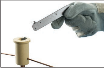
Fig. 15 – Apunte el encendedor desde el lateral, encienda el material de ignición en la cubierta del molde. Retire el encendedor rápidamente para evitar impurezas.
