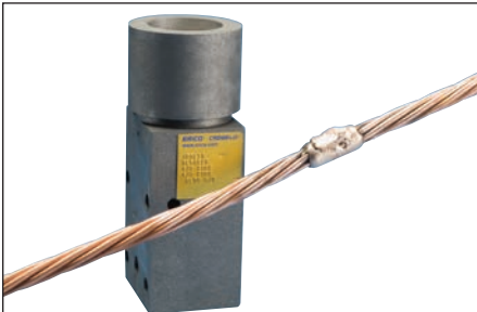
Fig. 31 – Listo para realizar otra conexión Cadweld.
