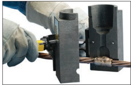
Fig. 28 – Abra el molde y retire la conexión. Tenga cuidado para evitar dañar el molde. Evite el contacto con materiales calientes. Consulte la sección “Estándares de calidad de soldadura en seco” para ver si se ha realizado una conexión de calidad.
