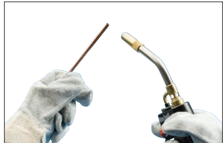
Fig. 4 – Los conductores deben estar limpios y secos antes de realizar la conexión. Use un soplete para secar los conductores de alambre y eliminar los residuos de limpieza, disolvente o agua restantes antes de realizar la conexión Cadweld One Shot.
