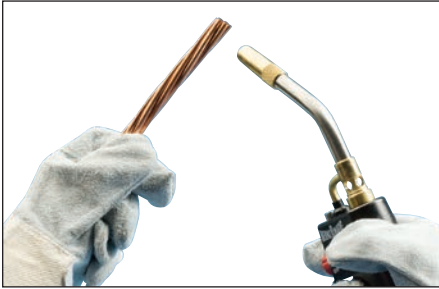
Fig. 11 – Los conductores deben estar limpios y secos antes de realizar la conexión. Use un soplete para secar los conductores de alambre y eliminar los residuos de limpieza restantes, disolvente o agua antes de realizar la conexión Cadweld.
