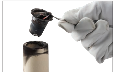
Fig. 14 – Retire y deseche el crisol usado del metal de soldadura Cadweld Plus.
