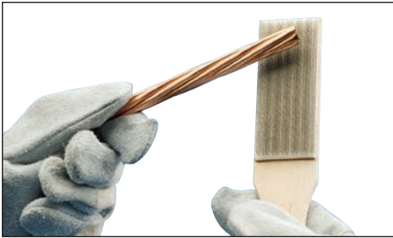
Fig. 12 – A continuación, utilice un cepillo metálico para preparar la superficie de los conductores (cepillo nVent ERICO T-313 o T-314). Raspe la superficie exterior para eliminar la suciedad y la oxidación. Notará un ligero cambio de color.
