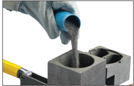
Fig. 20 – Vierta rápidamente el metal de aporte en el molde.
