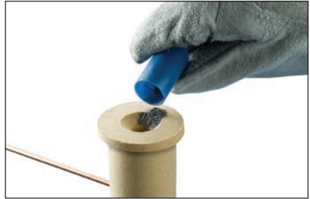
Fig. 14 – Vierta el material de ignición sobre la cubierta Cadweld One Shot.
