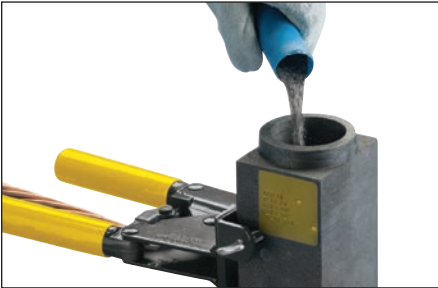
Afb. 21 – Giet het losse lasmateriaalpoeder in de Cadweld Exolon-mal.
