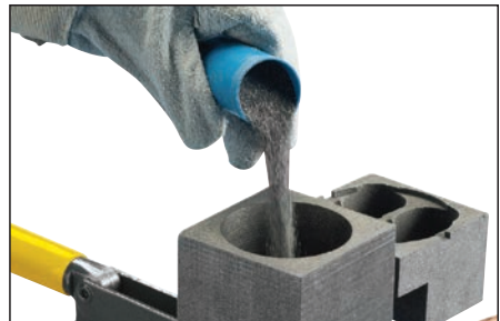
Afb. 20 – Giet het losse laspoeder snel in de mal.
