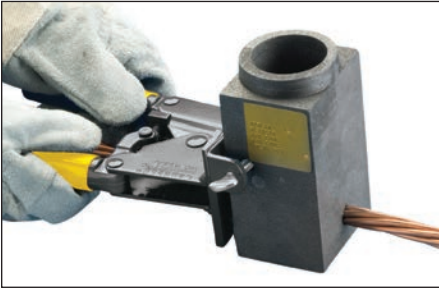
Afb. 16 – Sluit de klem strak zodat de geleiders goed zijn gepositioneerd.
