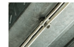
Cables & conduits from metal deck
