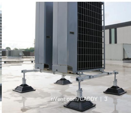
Los soportes de azotea Pyramid son una solución de montaje en superficie para el soporte de aplicaciones mecánicas y eléctricas en una variedad de superficies de las azoteas.
