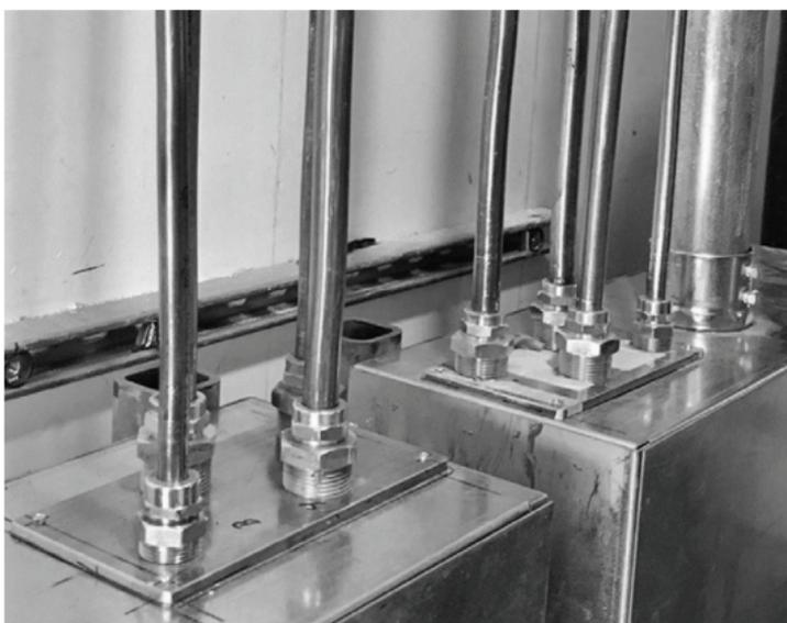
Entrée dans le bornier par la plaque de laiton
