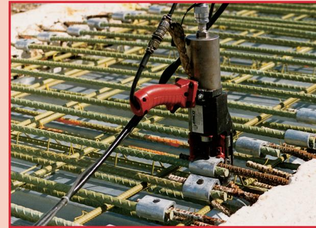
del limite di snervamento caratteristico della barra. Il sistema è inoltre in grado di sviluppare una resistenza pari al 120% del limite di snervamento caratteristico o al 110% del limite di snervamento reale per il CSA A23.3-1994 (utilizzando barre d'armatura G30.18-1992 grado 400MPa).
