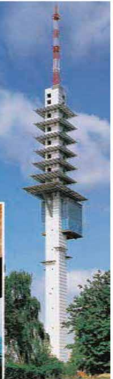
Fernmeldeturm - Hannover (D) Foto Ph. Holzmann AG, Frankfurt/Main.
