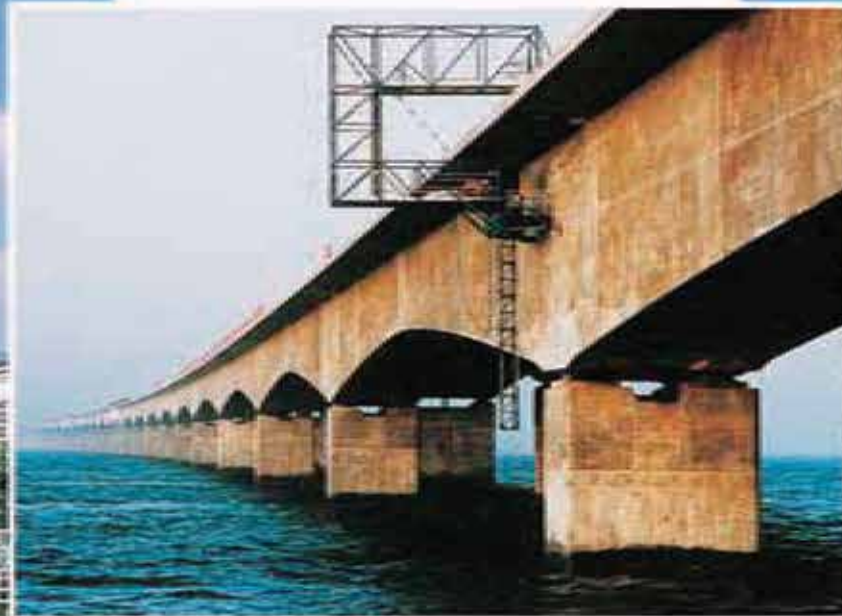
Storebælt west bridge (DK)
