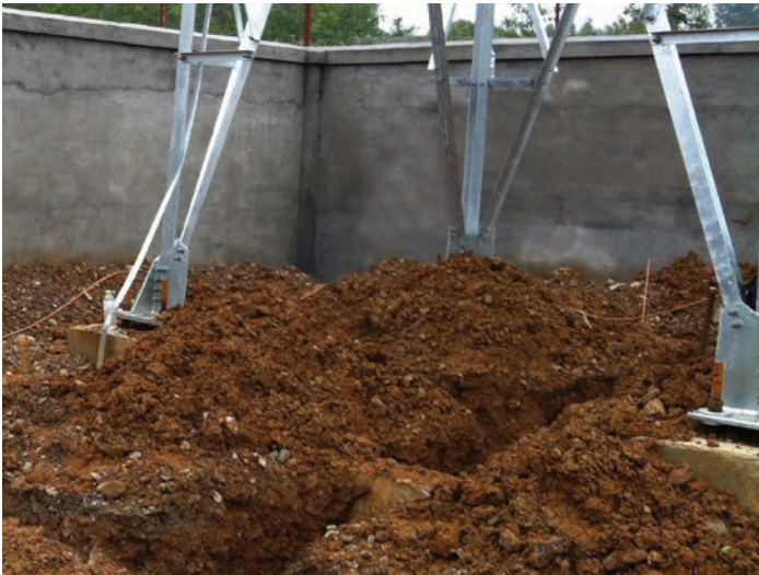
Erdung des Telekommunikationsturms
