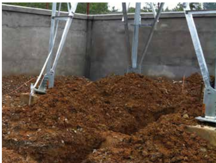
Mise à la terre des antennes de télécommunications
