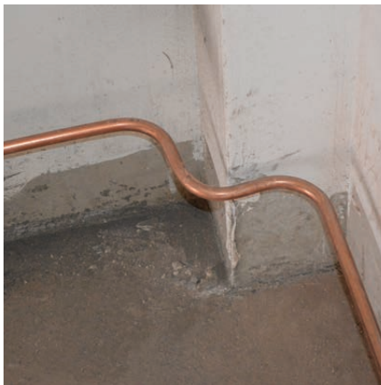
Equipotential grounding conductor
