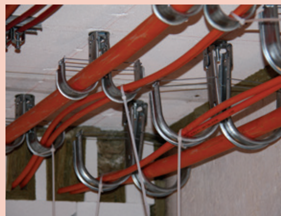
J-haken en kabels in de brandkamer voorafgaand aan de brandtest
