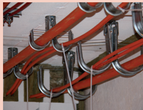
Crochets en J et câbles dans la chambre de combustion avant l'essai de résistance au feu
