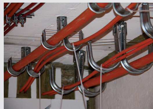
Haki J i kable w komorze ogniowej przed próbą ogniową
