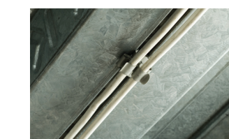
Kabels en leidingen vanaf staalplaat betonvloeren
