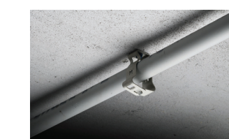
Buis op beton
