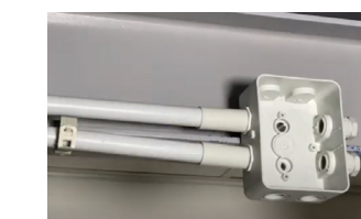
Elektrabuizen en opbouwdozen aan balken
