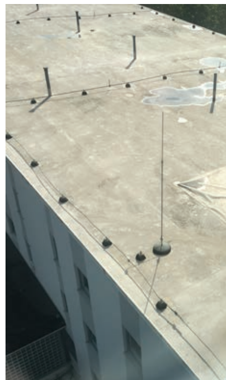
Eenvoudig beveiligingssysteem voor de wildgroei aan dakapparatuur
