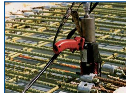
grado 60, vengono superati i parametri definiti dalla ACI318-02 per il Tipo 1, con una resistenza minima della giunzione pari al 125% del limite di snervamento caratteristico della barra. Il sistema è inoltre in grado di sviluppare una resistenza pari al 120% del limite di snervamento caratteristico o al 110% del limite di snervamento reale per il CSA A23.3-1994 (utilizzando barre d'armatura G30.18-1992 grado 400MPa).
