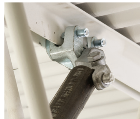
Universele bevestiging aan structuur CSBUNIVxxxEG – p. 18
