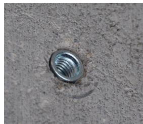
Antislingerbevestiging, montage met getapt gat CSBBRS3MEG – p. 38
