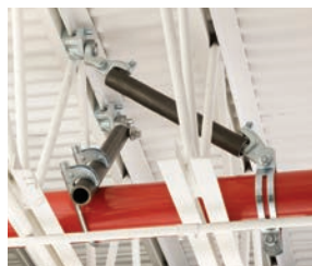
Fästpunkt för tvärbjälke CSBBARJEG – p. 14
