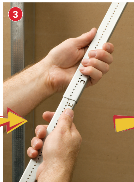
3. Deslize uma barra na parte superior da outra até ouvir um estalido.
