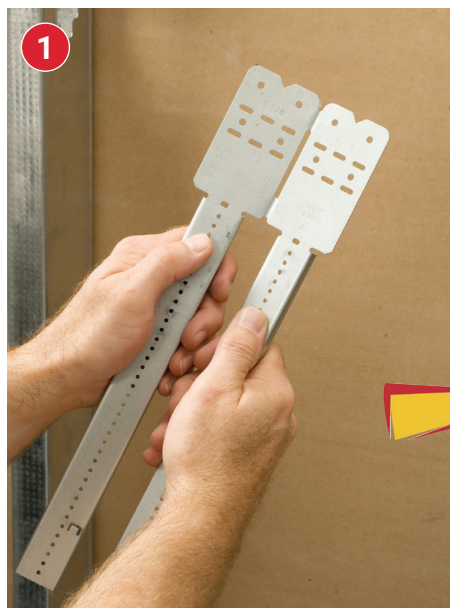
1. Curve a TSGB na marca indicada.
