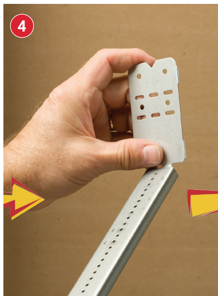
4. Curve os separadores laterais na primeira marca.
