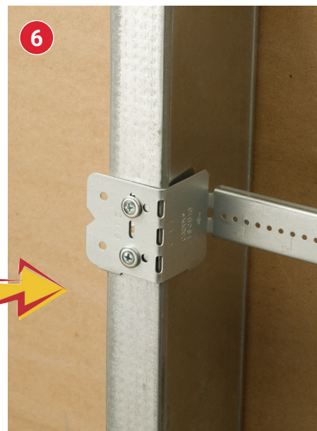
6. Instale a TSGB no suporte com o parafuso de baixo perfil, Artigo nº 187197.
