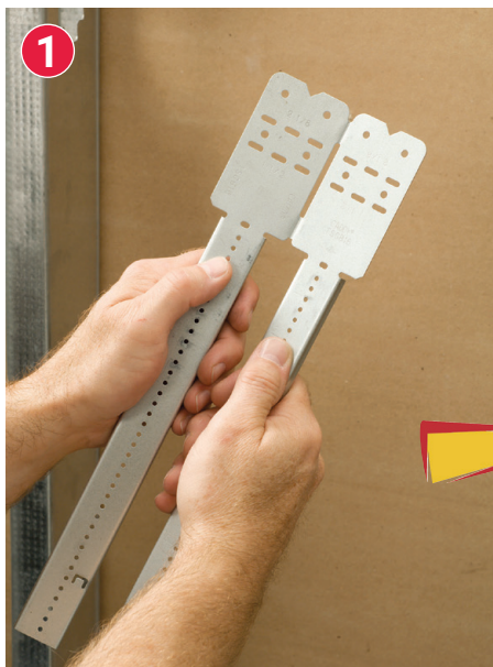
1. Zegnij wspornik TSGB w miejscu nacięcia.
