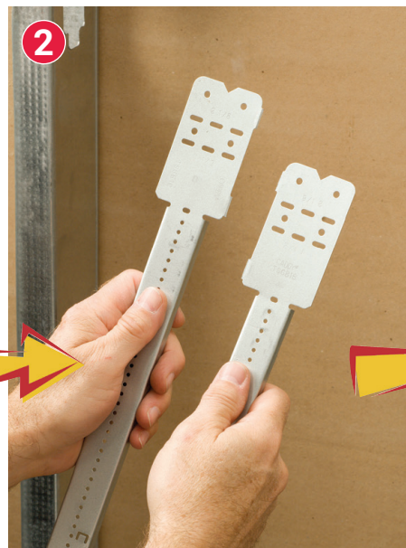
2. Rozdziel wspornik na dwie części.
